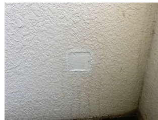
(固化および簡易補修後)
